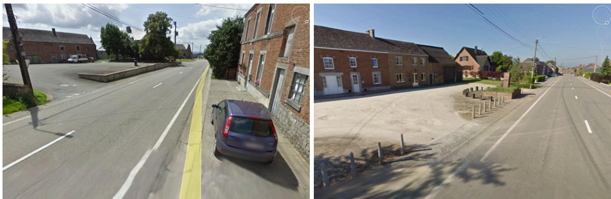
Figures 8 et 9 : Mont-Gauthier, largeur carrossable à réduire, trottoirs à agrandir, espaces « places » à réaménager (effet couloir exacerbé par les développements de lotissements sur la N929)
