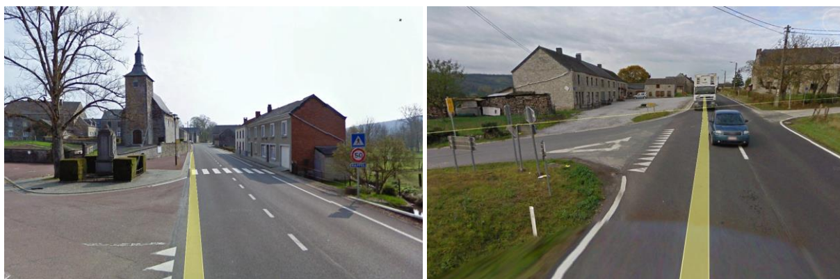
Figures 2 et 3 : Ave et Auffe, trottoir à élargir du côté droit et à Auffe « place » à aménager.
