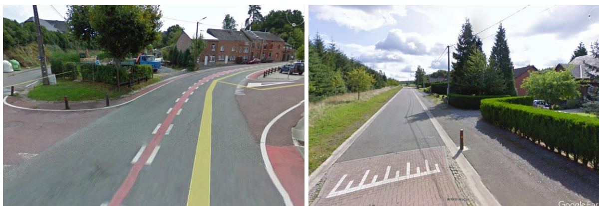
Figures 12 et 13 : Villers-sur-Lesse, espace public central à réaménager (trottoirs) – Jambline, dispositifs ralentisseurs non uniformisés, le long des développements de lotissements.
