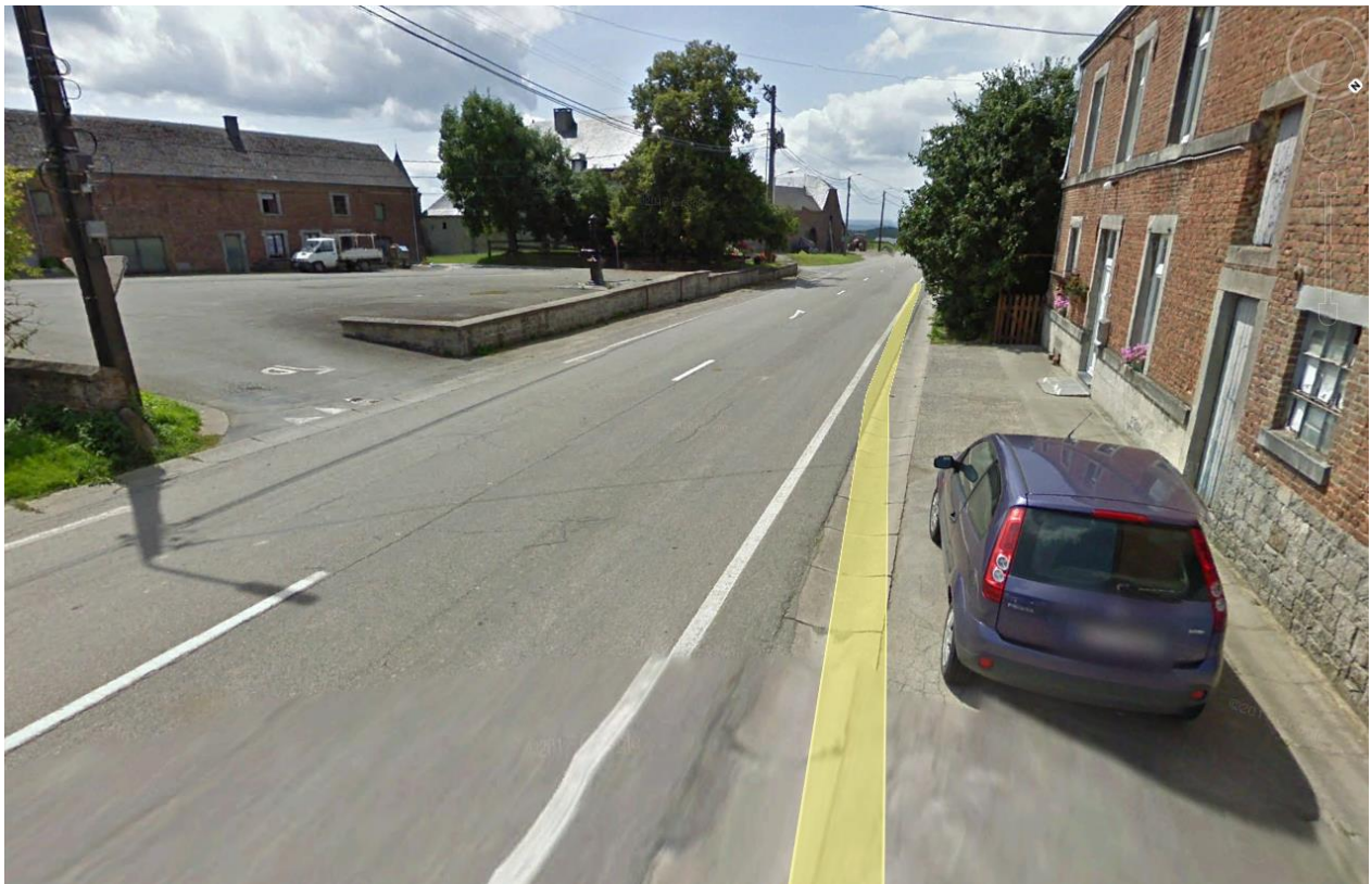
Figure 2 : Mont-Gauthier, entrée ouest, trottoirs à agrandir, placette à réaménager (Source : Streetview 2018)
